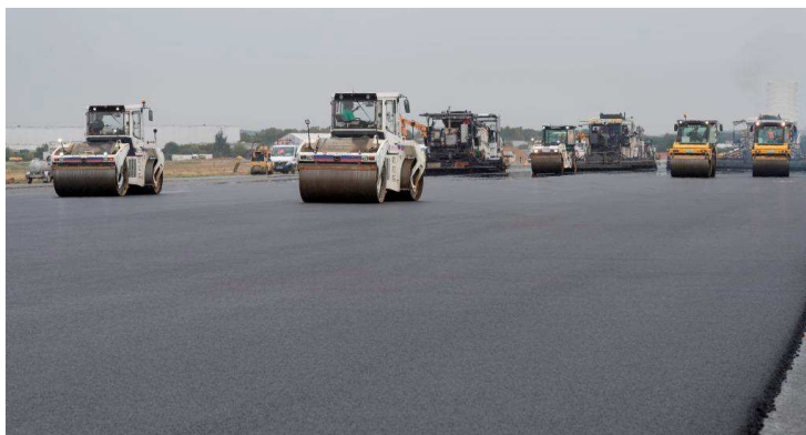
Les travaux de la piste 4 en 2017 Photo Groupe ADP- Alain Leduc
