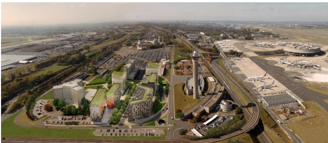
Perspective du quartier Roissypole Ouest sur l'aéroport Paris-Charles de Gaulle ©Groupe ADP
