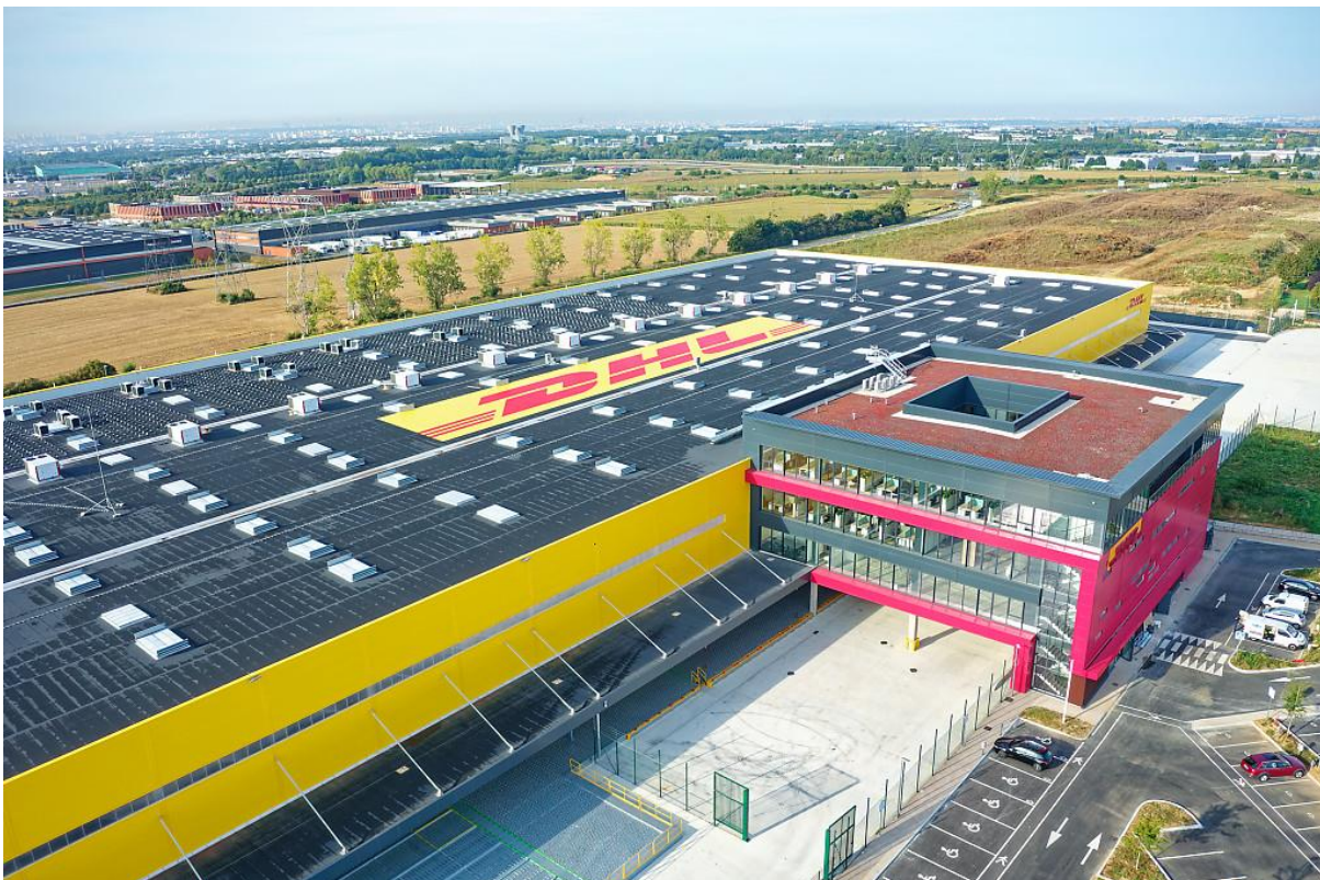
Nouveau hub logistique de DHL Express sur la "cargo city" de l'aéroport Paris-Charles de Gaulle © DHL Express
