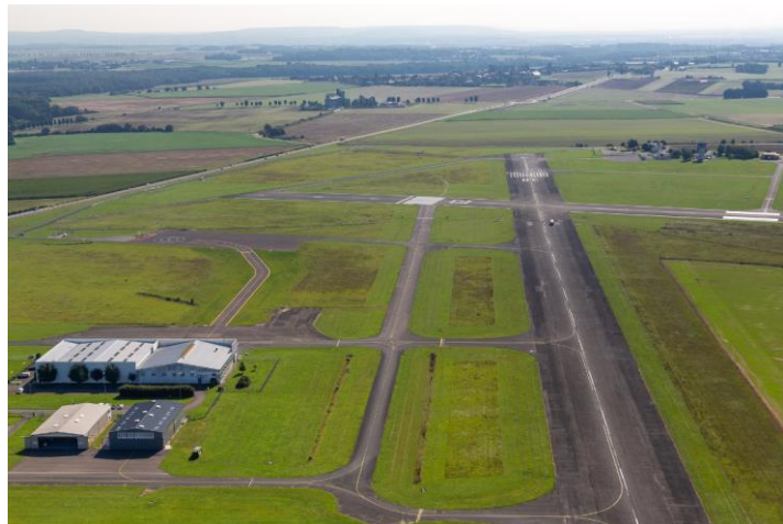
Vue de la zone de test sur l'aérodrome de Pontoise © Groupe ADP
