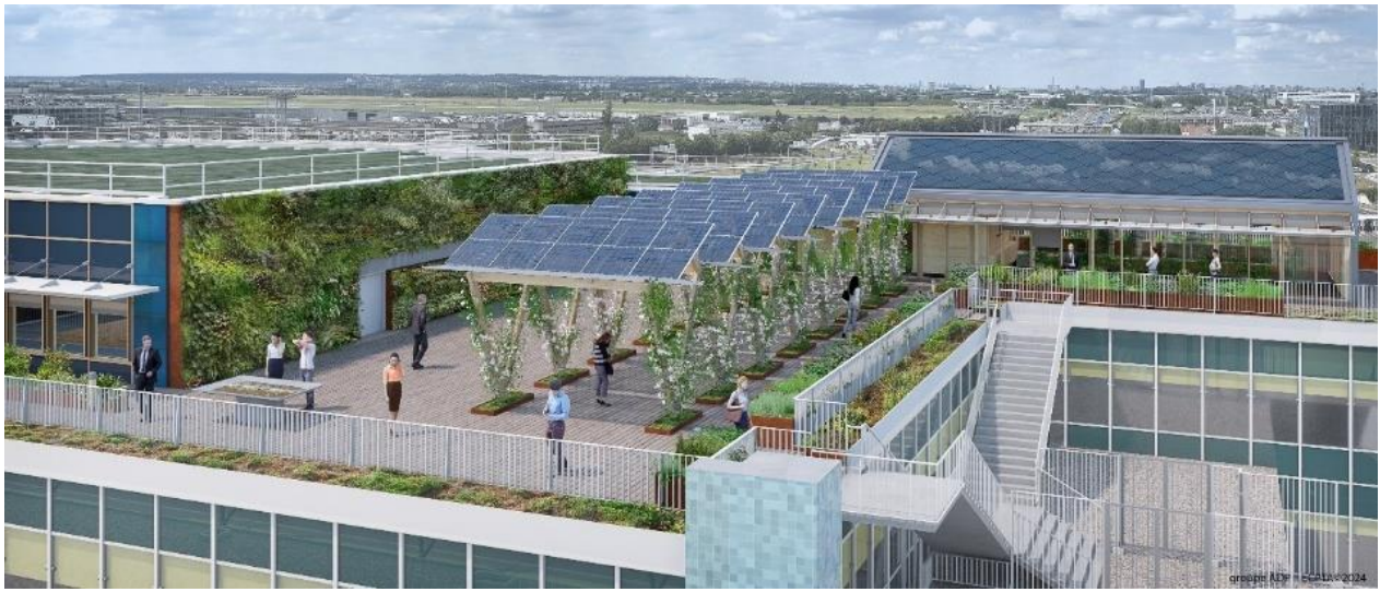
Transformation du niveau 6 à Orly 4 incorporant une nouvelle façade à haute performance énergétique
